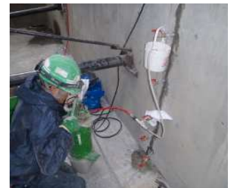
ひび割れ注入状況
