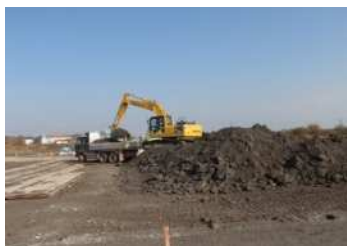
④改良土を解砕し積込運搬
