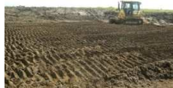
⑤築堤基盤に敷均し
