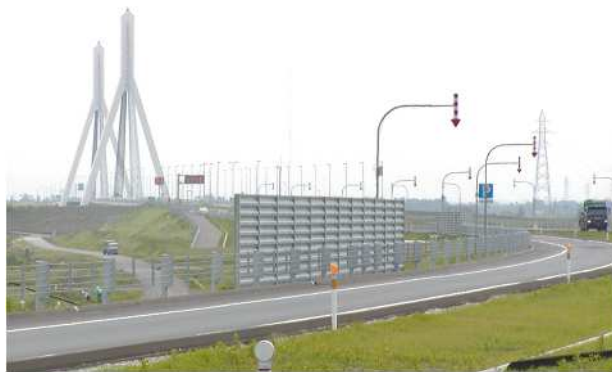
泥炭性軟弱地盤上に整備された高規格道路。 道路盛土の基盤には深層混合処理がなされている。
