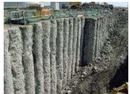
深層混合処理で固化された改良体
