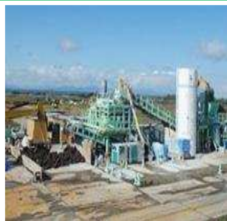
固定式プラント
