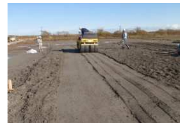
⑥転圧し築堤構築
